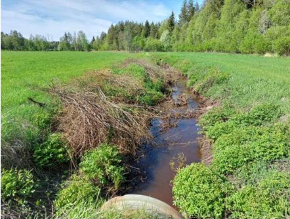
Kuva 16. Kaksitasouoman suunniteltu alkupää rummun jälkeen. Tulvatasanteen kaivu kuvassa uoman oikealle puolelle.
