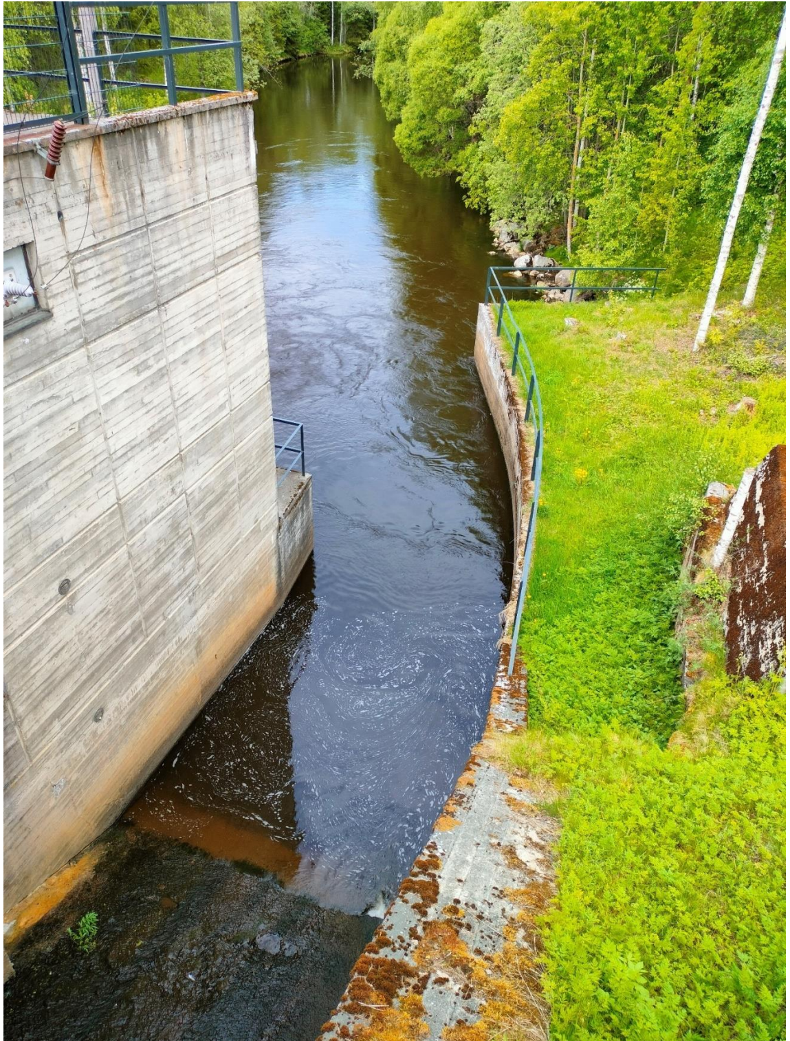
Kuva 21 Vesikosken voimalaitos ja tulvakanava.
