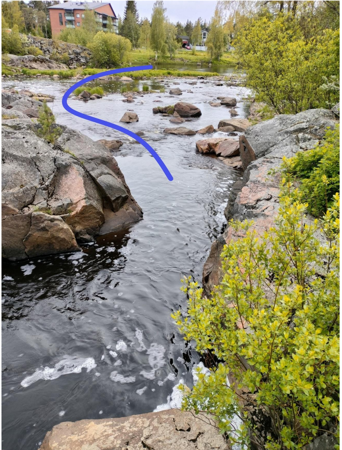
Kuva 23 Hourunkosken alemman kalatien veden ohjaus voimalaitoksen alapuolelle.
